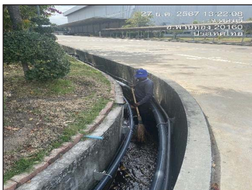
ภาพที่ 19 ขุดลอกรางระบายน้ำฝน
