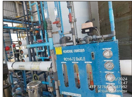
ภาพที่ 17 ระบบผลิตน้ำแบบ RO
