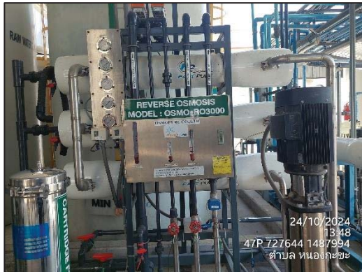
ภาพที่ 17 ระบบผลิตน้ำแบบ RO
