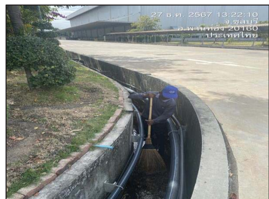
ภาพที่ 19 ขุดลอกรางระบายน้ำฝน
