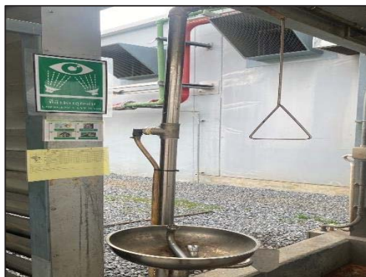
ภาพที่ 42 อุปกรณ์ชำระล้างฉุกเฉินกับบริเวณที่ต้องทำงานสัมผัสกับสารเคมี
